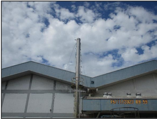
ภาพที่ 2.1 ปล่องระบายอากาศของหม้อผลิตไอน้ำ (Boiler Stack)
